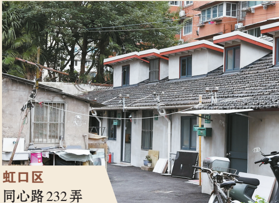
■ 修缮后的危房面貌焕然一新
