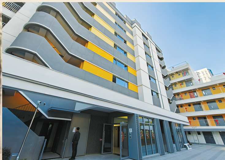
■ 漕河泾街道漕溪三村旧住房原拆原建项目交付,172证居民“旧房换新颜”
