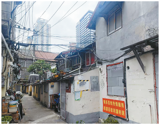
■ 729街坊大部分居民已搬离，不少房屋大门被砖块封堵(摄于昨天)
