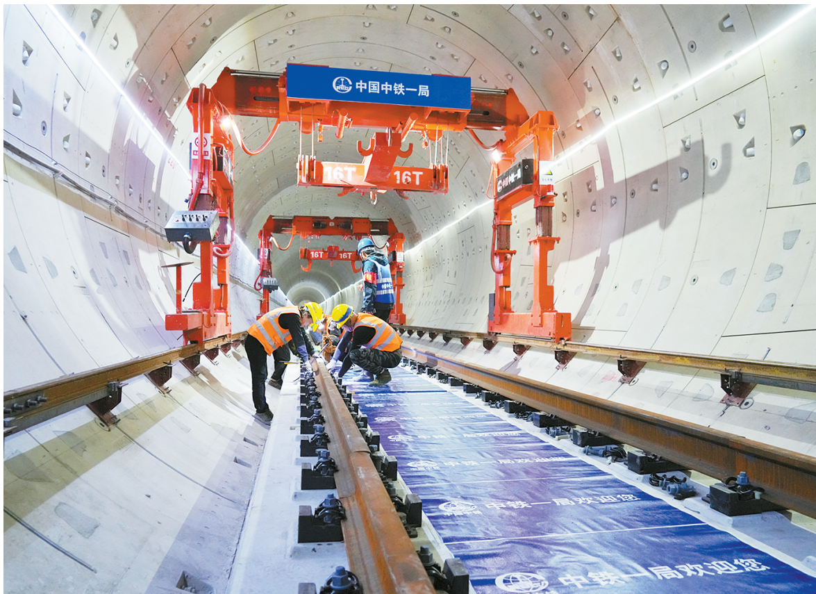
■ 今天上午,上海市轨道交通21号线佳林路站,由中铁一局承建的轨道施工2标启动铺轨仪式,标志着21号线工程建设迈入轨道工程施工的新阶段。图为佳林路站铺轨基地施工现场 本报记者 张龙 摄
