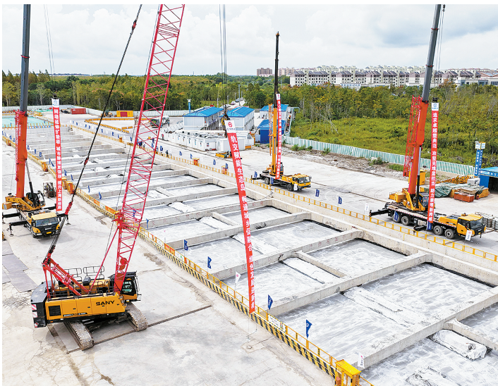
■22号线全线建设的关键节点之一——终点站裕安站车站顶板顺利浇筑完工 本报记者 陈梦泽 摄
