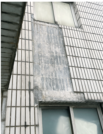
▲居民车辆挡风玻璃被砸出一个洞 ▲瓷砖脱落处 ▲瓷砖脱落的2号楼
