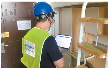
▲校园突击小队利用暑假期间，争分夺秒完成校园网络升级工程
