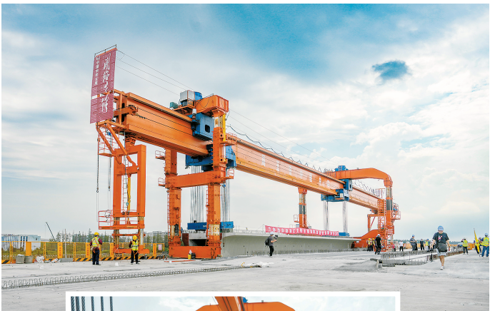
▲ 榀箱梁架设完成 ▲ 昨天,南汇支线主线最后一
