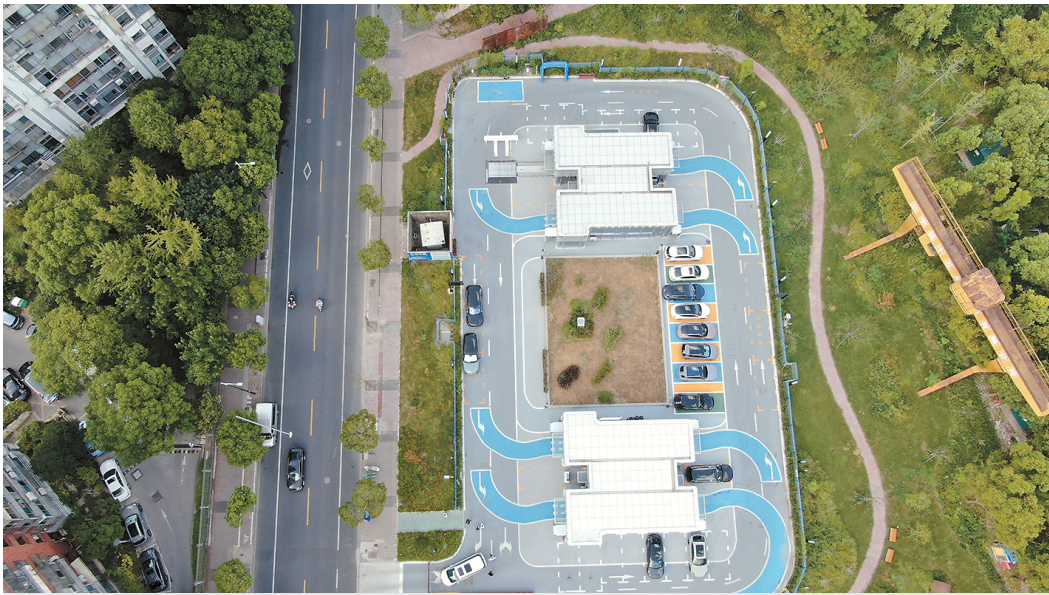
■ 静安大宁EUP竖井智慧停车场建成运营，大大缓解了附近小区居民的“停车难” 本报记者 陈灵玮 摄
