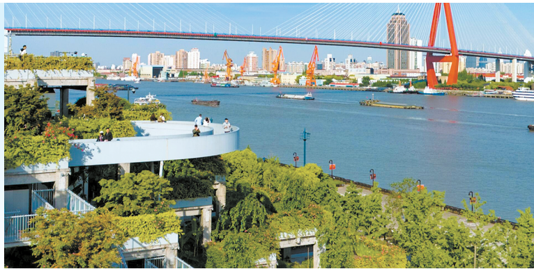
■ 原烟草仓库经过更新改造成为绿之丘 公共空间
