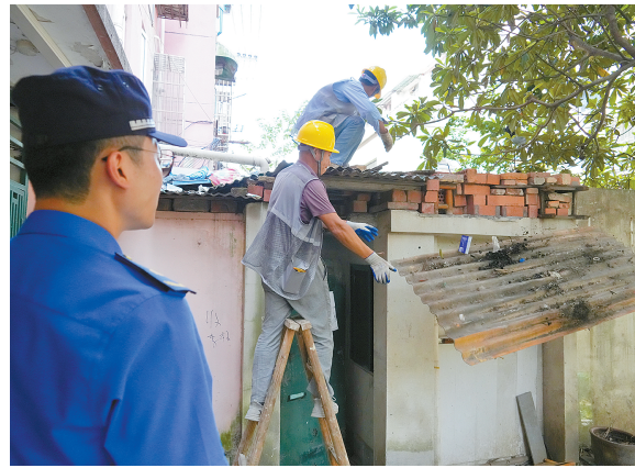
■位于徐汇区日晖六村的违法搭建被城管部门拆除 本报记者 张龙 摄
