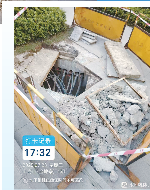
■路面施工，影响业主通行
