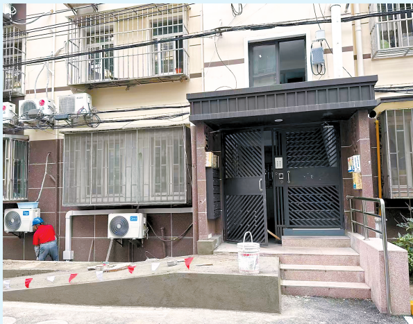
虹口区王老伯家楼前增建无障碍坡道
