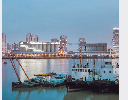
▲ 民生码头8万吨筒仓改造工程
