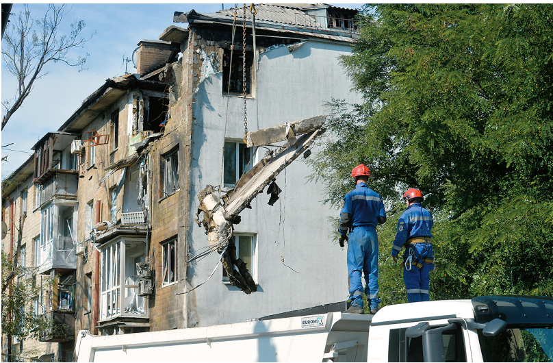
乌克兰拆除在俄军空袭中受损的居民楼
