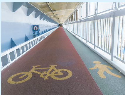
■ 闵浦三桥的“空中人非通道”
