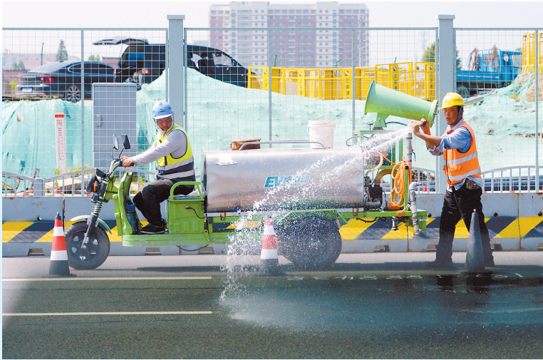
■ 在浦东周邓公路上，市政建设者在烈日下进行道路施工时洒水降温
