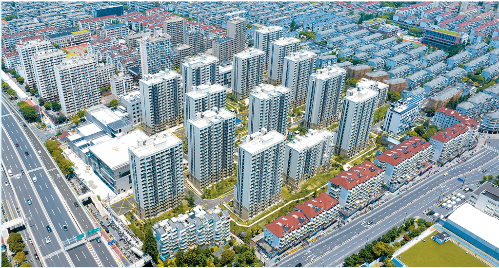
■ 彭一小区原40幢旧房变为17幢崭新高层电梯住宅
