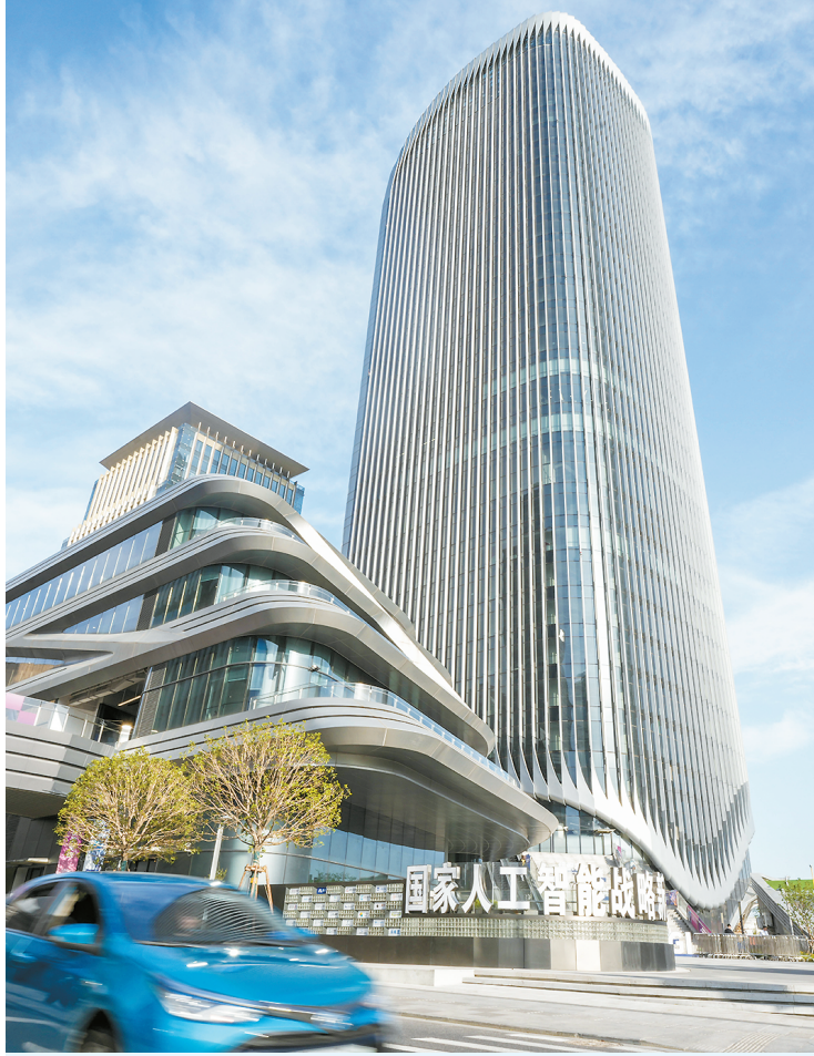
▲ 位于徐汇西岸的国家人工智能战略新兴产业集聚区
