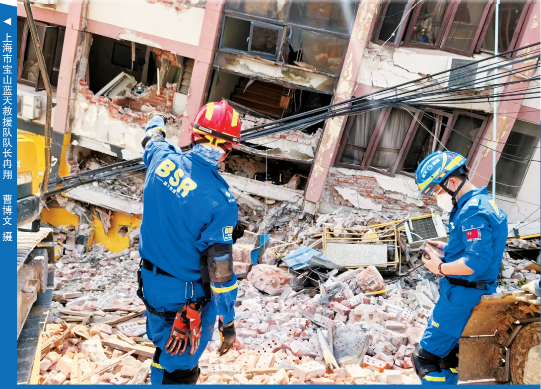
救援队员在坍塌的白云宾馆操作雷达生命探测仪进行搜救
