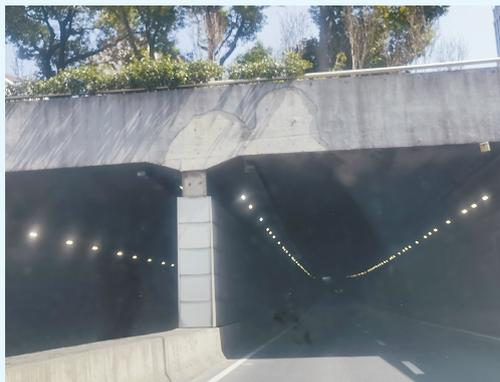
地道洞口上方“门头”处几大块墙皮脱落
