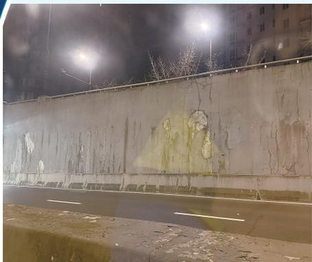
地道出入口敞开段,墙面大面积积掉皮
