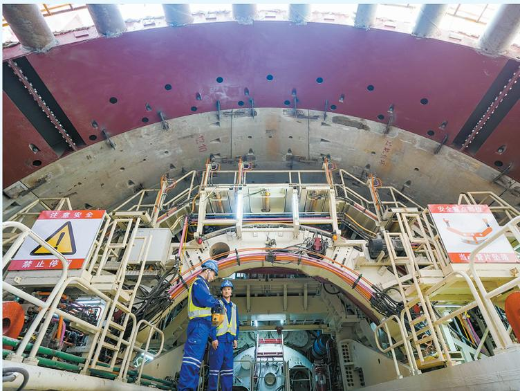
南汇支线项目建设今天迎来新突破。在1标位于下盐路站的始发井内,国产自主研发的14米级超大直径盾构机“申拓号”整装待发。作为南汇支线最大的盾构,“申拓号”即将开启下盐路站至T3航站楼站盾构区间掘进任务。至此,南汇支线全线所有盾构区间均已进入掘进施工阶段。
