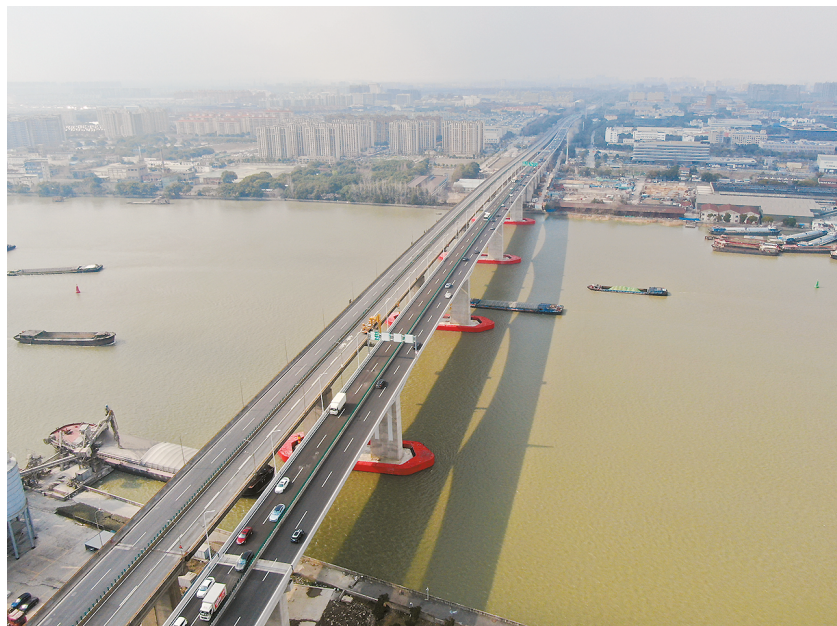
■ 奉浦东桥（右）昨全面通车，奉浦大桥（左）将封闭改造
