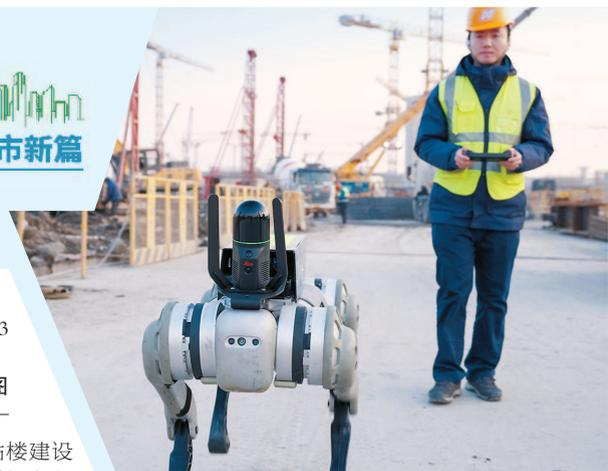
走进浦东机场T3航站楼建设工地,轰鸣的各类大型机械设备与穿梭其间的工人共同编织出一幅忙碌而有序的施工画卷。在这片热火朝天的建设场景中,一群身着统一制服、手持背负测量设备和三脚架的工作人员尤为引人注目。他们或蹲或站,在工地各处进行精准的测绘工作。这群来自上海市测绘院的技术人员中,有一位正操作着新颖的机器狗进行测绘。
