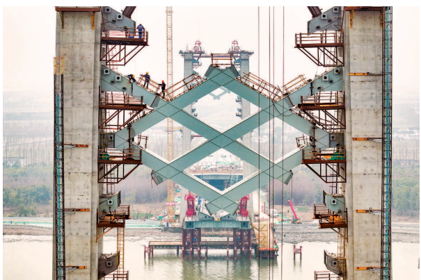
▲ 在建中的嘉松公路越江大桥 ▼ 嘉松公路越江大桥主塔上以窗花为原型的菱形钢结构 本报记者 陈梦泽 摄
