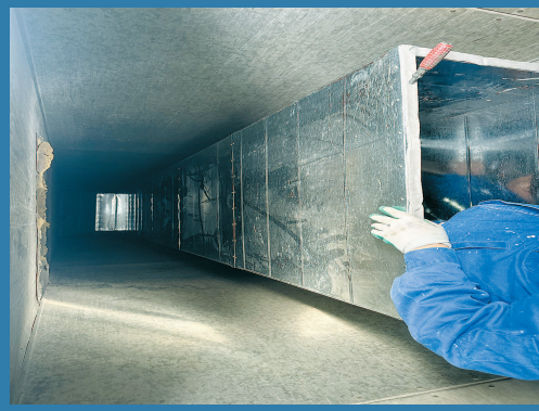
完成 经多方沟通,管道改造工程已实施 受访者供图
