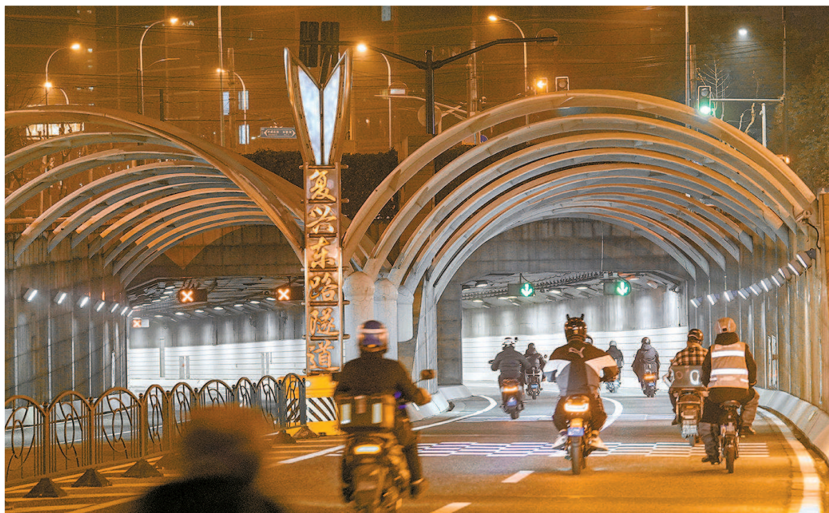
■ 昨天23时,复兴东路隧道上层开放供电动自行车通行
