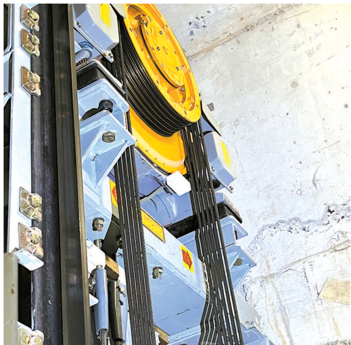
无机房电梯直接固定在客厅墙壁另一侧，虽张贴隔音棉，但电梯升降引发墙壁共振
