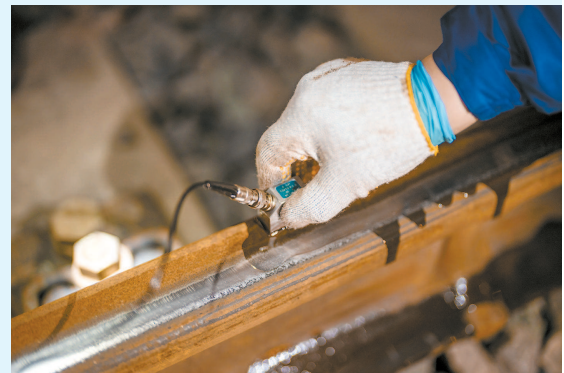
每个焊缝都须完成纵向、横向、斜向三道扫查
