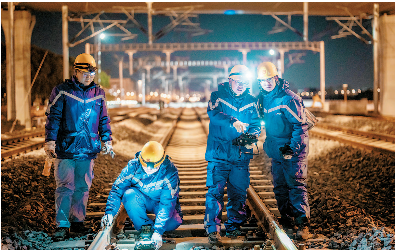
组长向斌带领组员手持超声波探伤仪,俯身零距离观察轨头、轨腰、轨底不同部位,以探头覆盖焊缝全断面
