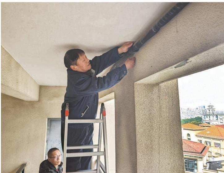
■今天上午,金山区山阳镇海滨新城物业人员对小区居民楼自来水管道进行巡检,并对部分外露自来水管用保温棉进行包扎,防止冰冻影响居民用水
