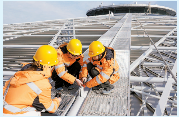
▲ 班组成员遇到焊缝螺栓就弯腰查看,用榔头敲击检查
