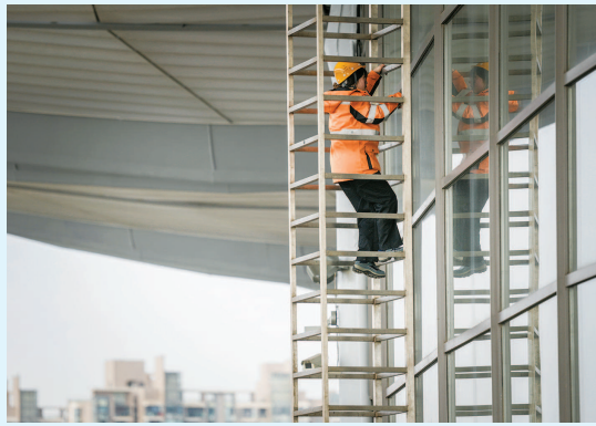
▲ 要爬上南站屋顶,数十米高的垂直爬梯是必经之路
