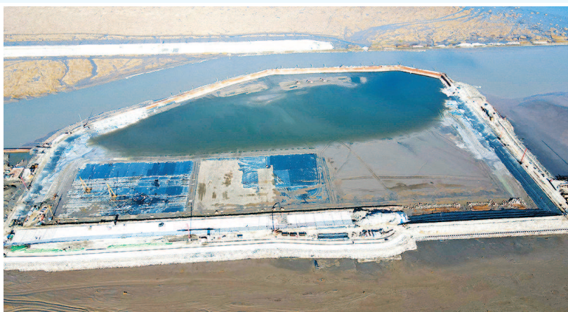
大芦线东延伸航道整治工程枢纽围堰正式合龙
