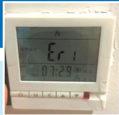
居民家中的太阳能储热系统控制面板始终显示“错误”
