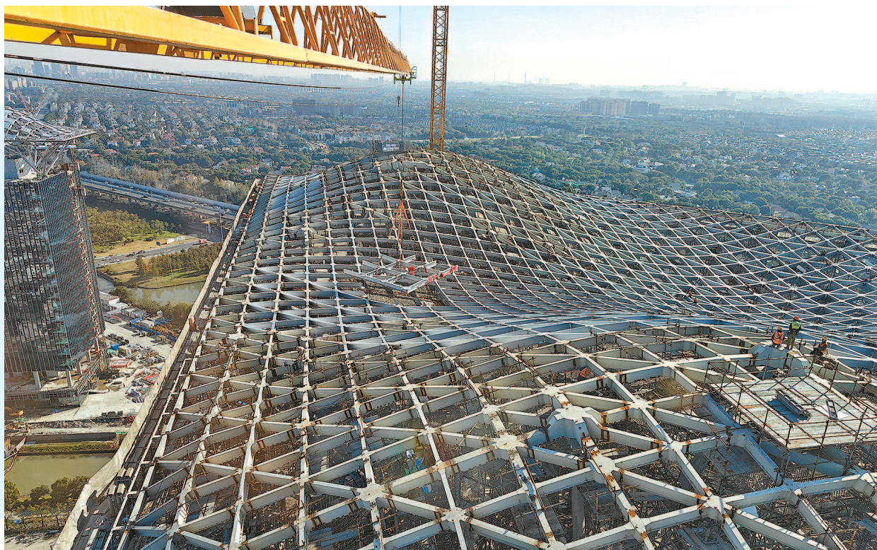
■ 今天上午,二期云顶最后一片网壳吊装到位
