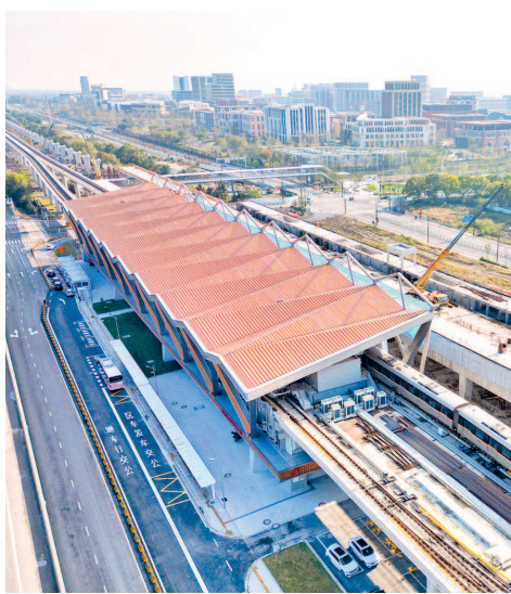
西岑站屋顶就像折叠的扇面 本报记者 张龙 摄
