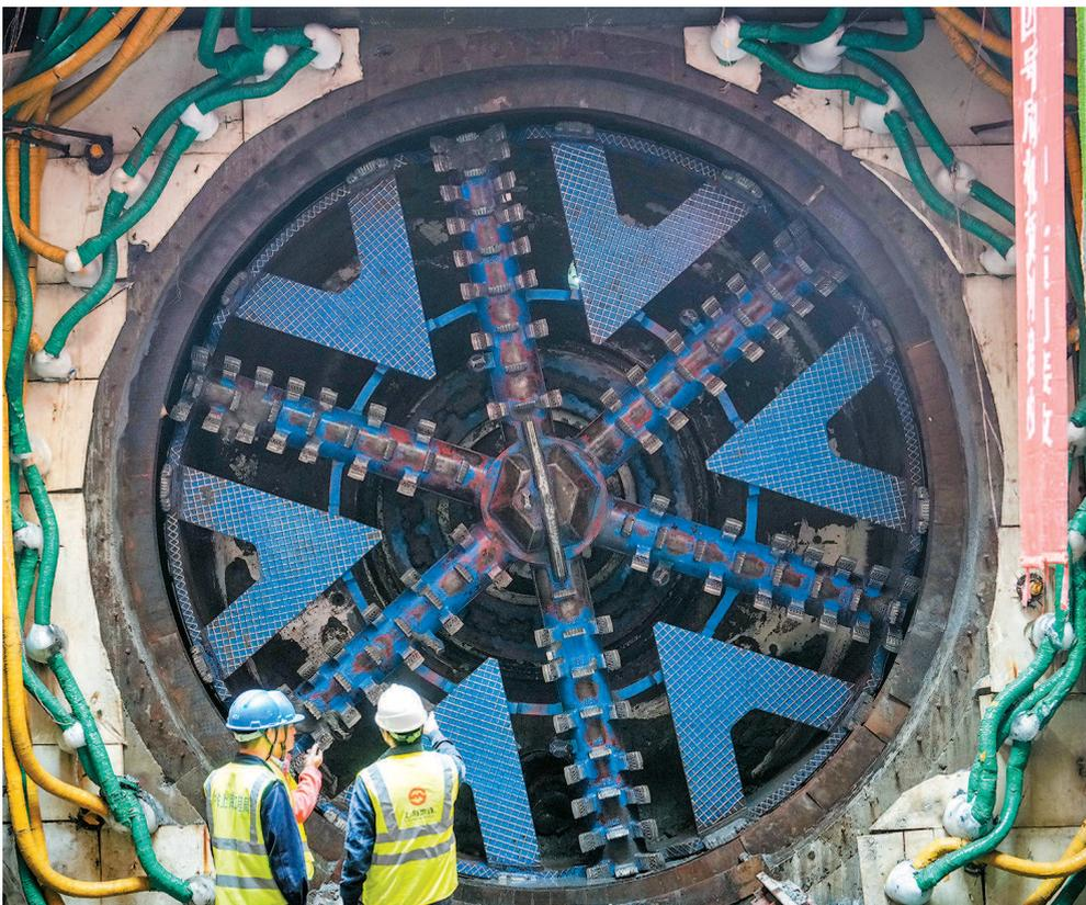
上午,随着盾构机刀盘缓缓转动,轨交18号线二期盾构区间全线贯通
