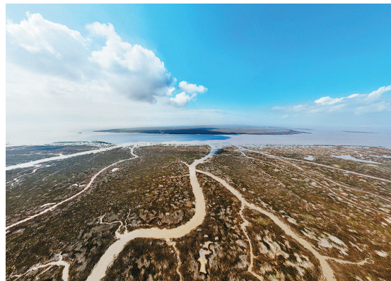
九段沙湿地保护区错综复杂的水道宛如一棵巨型大树
