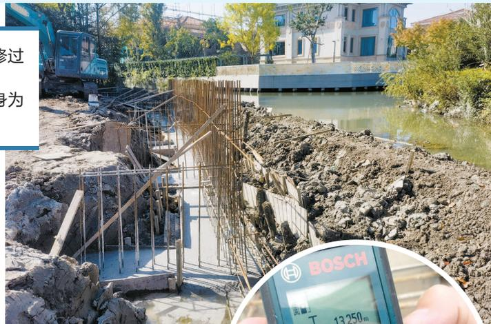
▲ 工地沟槽处正在建设驳岸,外侧是河道堆泥,内侧是土岸
