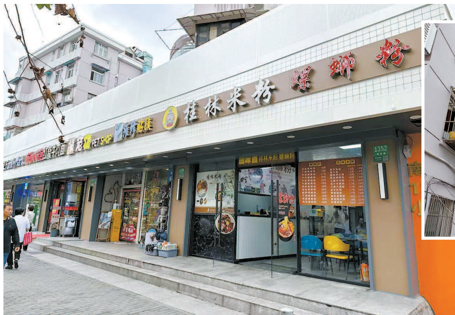
▲ 设置在南泉北路1350弄小区公共外立面上的“共享烟囱” ◀ 众多沿街小吃店与居民楼仅一墙之隔 本报记者 徐驰 摄
