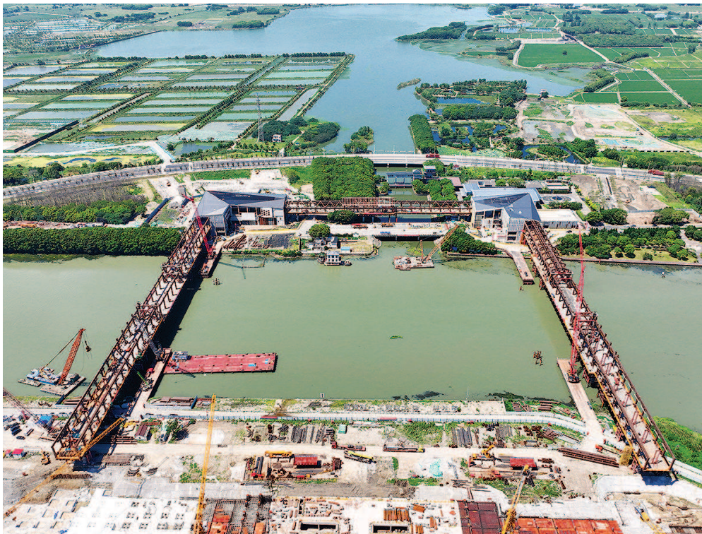
建设中的方厅水院
