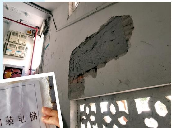
楼内墙皮被凿开,前期勘查安装条件的工作已完成
