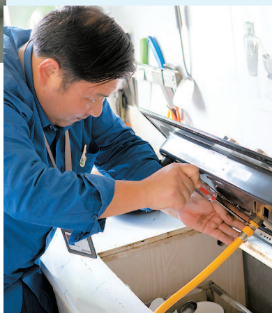
▲ 上海燃气工作人员帮用户更换金属软管
