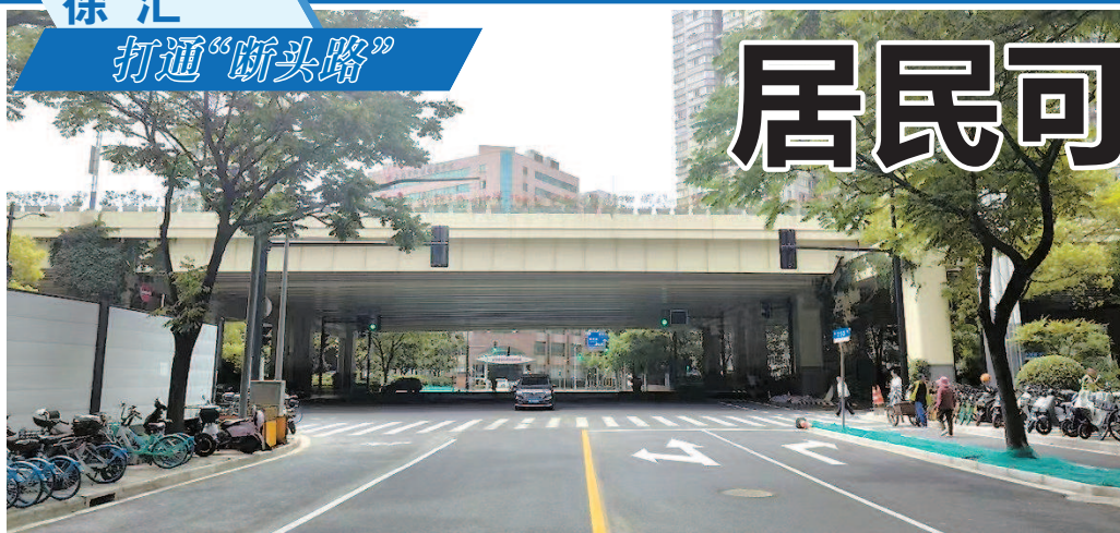
■ 定安路沪闵路交叉口交通改善工程,大大方便了沪闵高架两边的居民
