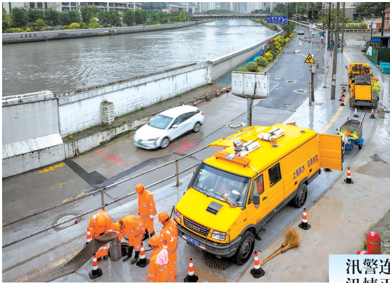
今天上午，在苏州河旁长寿路桥地道入口处，一支防汛应急抢险队伍正在对市政管网水位进行预防降施工，以确保易积水路段安全畅通 本报记者 陈梦泽 摄
