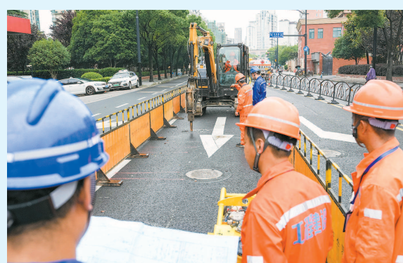
老化燃气管道改造工程启动。本报记者 陈梦泽 摄
