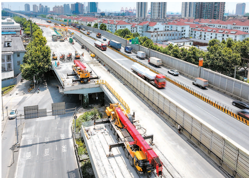
■ 今天上午,泰和路高架桥一半路面封闭施工,陆续更换新旧板梁 本报记者 陈梦泽 摄
