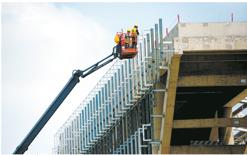
作为长三角一体化“大动脉”的沪苏湖铁路正在紧锣密鼓地施工建设 杨建正 张锡峰 摄
