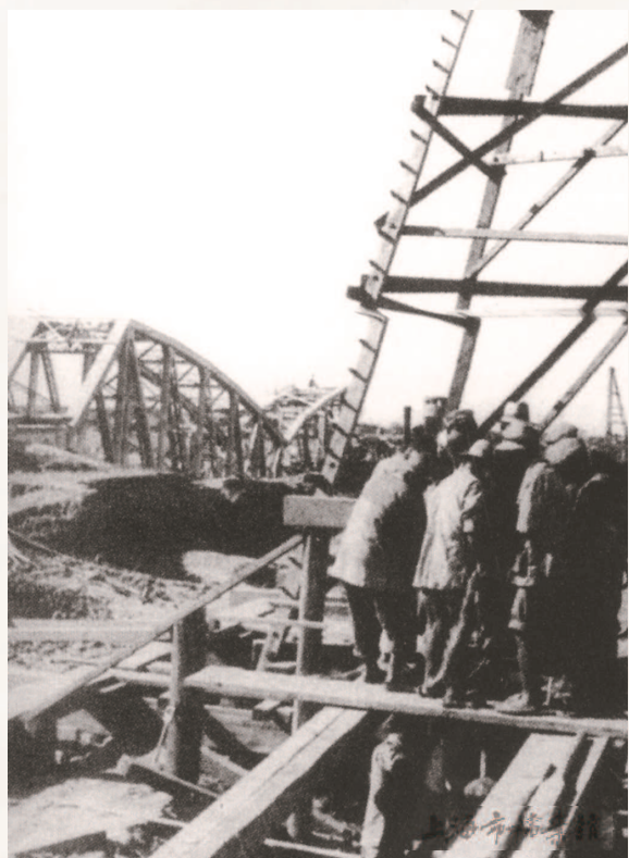
■ 工人正在抢修被毁的桥梁
