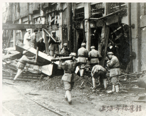
■ 驻厂部队协助工人清理上海电力公司三号锅炉炉
