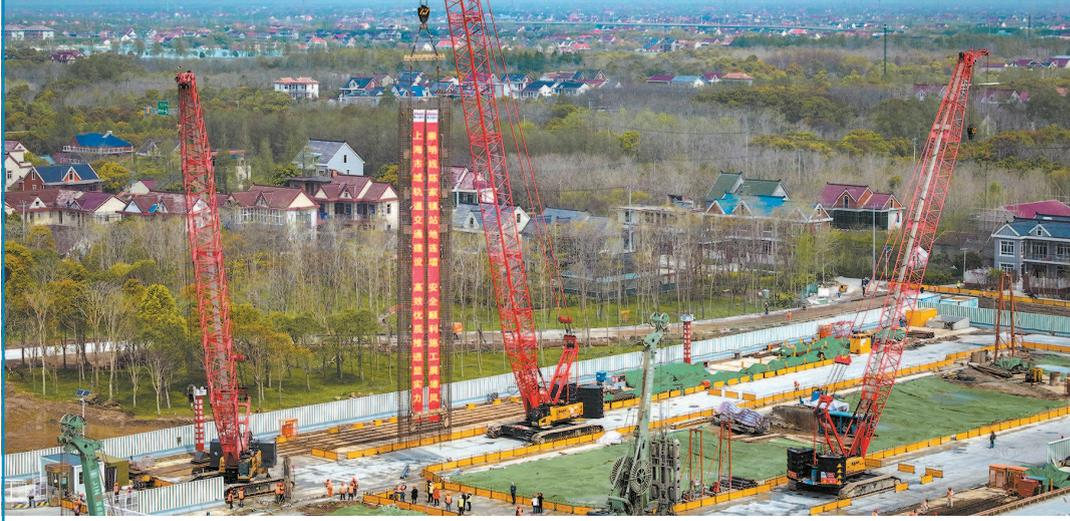
■ 今天上午，上海轨道交通崇明线陈家镇站地下连续墙钢筋笼起吊、入槽
