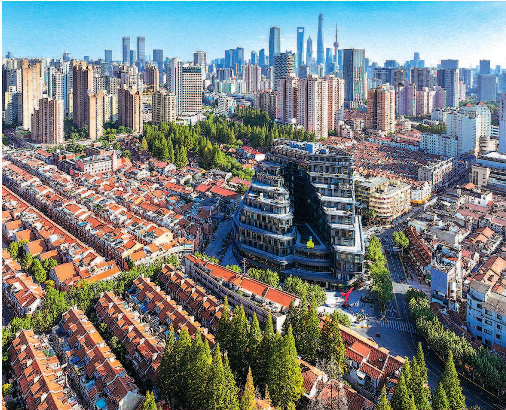
■近年来，上海城市更新不断加速。图为山阴路优秀历史建筑、里弄房屋整体修缮焕新后，重现历史风华。老建筑在“修旧如旧”中融合现代功能，化身市民游客喜爱的文化地标，同时也成为周边百姓的社区会客厅 本报记者 陈梦泽 摄
