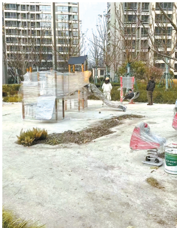
■ 公区建设尚未完成
